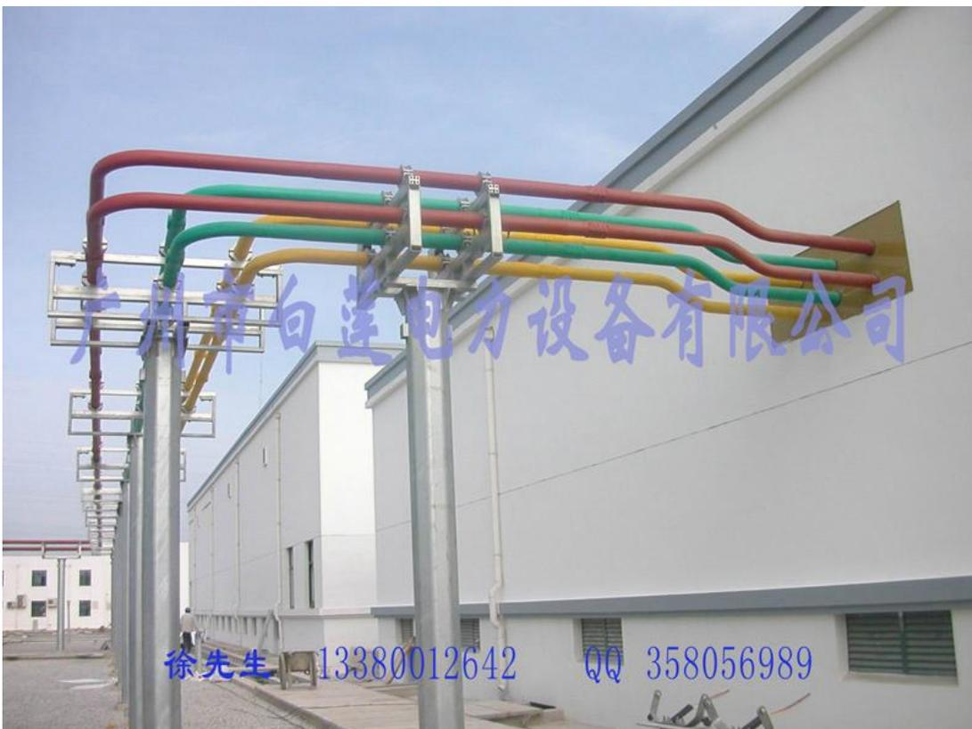
绝缘铜管母线图片
