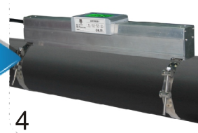
安装完成，开始测流量
